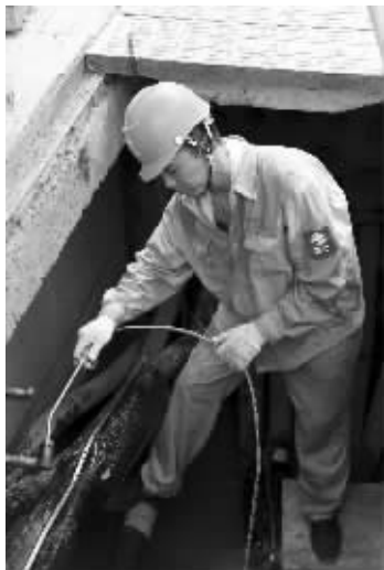
宋晨杰在对电缆做防水封闭施工
