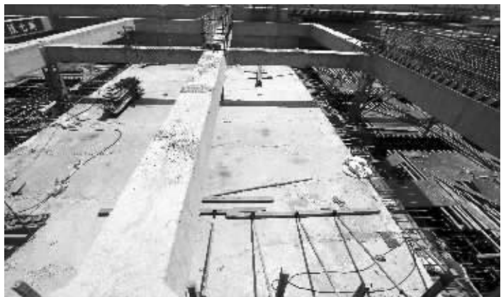
轨交4号线南门路站已经开始顶板浇筑
