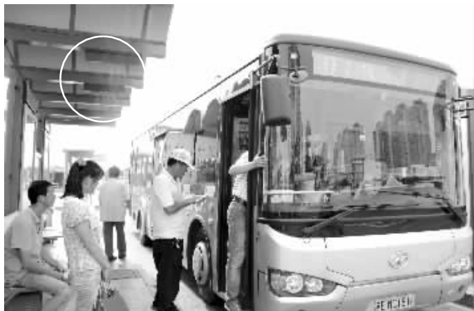
汽车客运站固定式喷雾降温系统(画圈处为喷雾口) 罗光灿 摄
