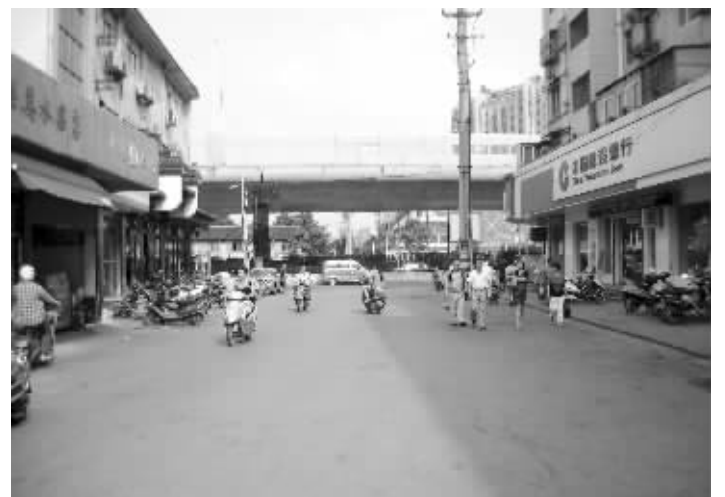
五河新村出入口整治后变得整洁畅通
