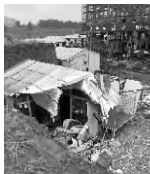
被土墙坍塌埋压的活动板房 新华社记者 詹彦 摄
