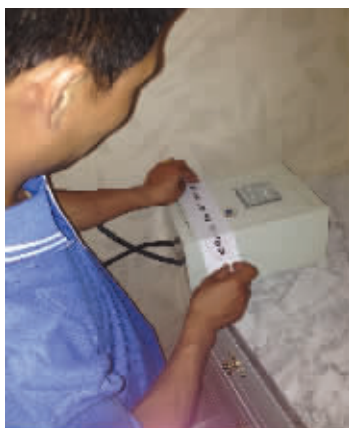
电表箱、空调电源插座和连接电表箱的插座均贴上封条,工作人员收走空调遥控器,保证无法对空调进行任何用电操作
