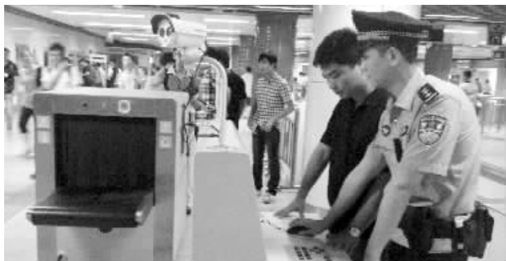
已安装到位,正在调试的安检机 现代快报记者 李绍富 摄
