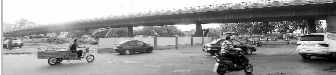
晓庄广场的跨线桥即将拆除 现代快报记者 赵杰 摄
