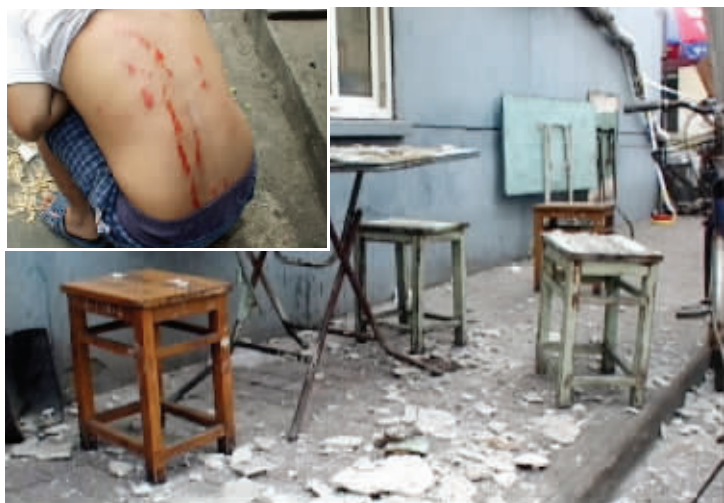
左上角图为小朱背部被砸出血印;大图为脱落的水泥散落在地上 现代快报记者 陈志佳 摄
