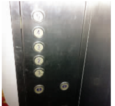
有人在吗?快打96333报修,这台电梯怎么关不了门啊? 6月15日摄于桥北金盛国际家居 (作者 杜仁雨)
