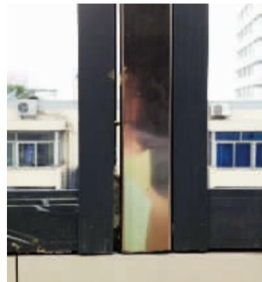
阳光房板块尺寸相对照，并按分格安装位置编号，保证阳光房胶缝的一致性。阳光房板块上的铝合金附框，用外压板通过螺栓、螺母与立柱横梁连接固定。阳光房全部外露金属件（压板），从任何角度看均应外表平整，不允许有任何小的变形、波纹、紧固件的凹进或凸出。安装好的阳光房表面应平整，不得出现翘曲等现象。
