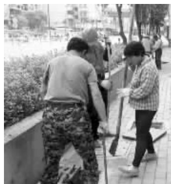
工作人员在疏通污水管网
