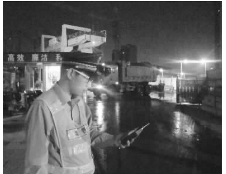
对工地施工噪声进行测试
