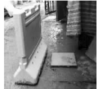
化粪池盖上新盖板 现代快报记者 顾元森 摄
