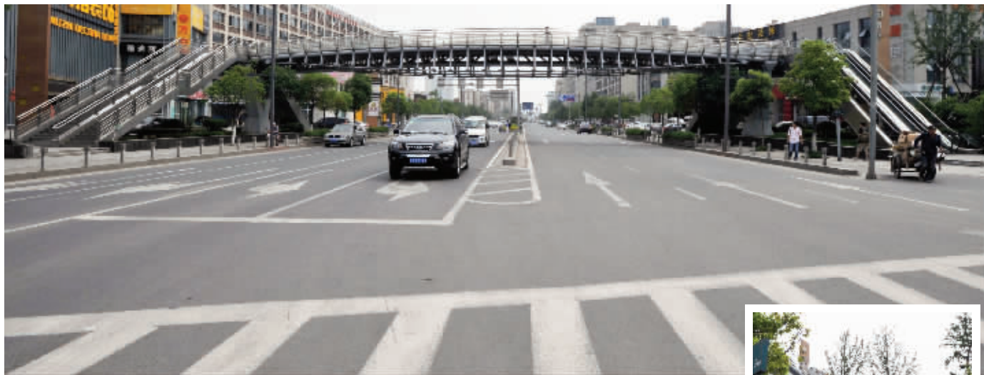
这座豪华天桥距离旁边的过街斑马线,仅仅8米 现代快报记者 马晶晶 摄
