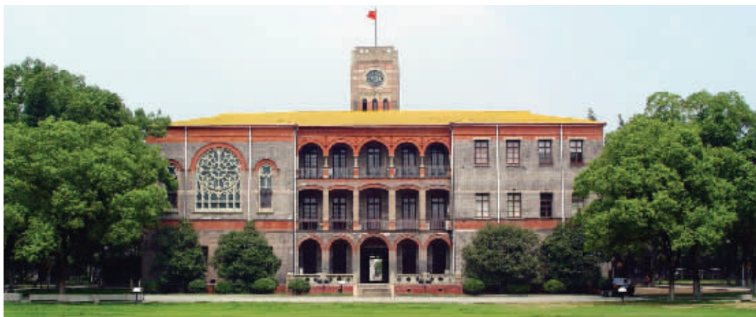
东吴大学旧址的钟楼 图片均由苏州大学提供
