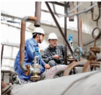
检查锅炉安全保护装置
