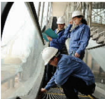
对高铁站自动扶梯进行安全检验
