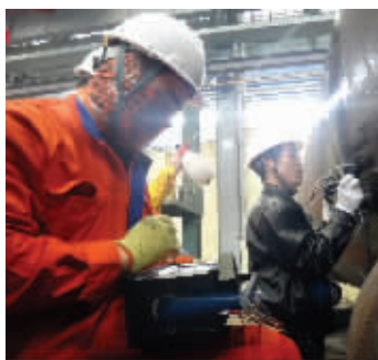
对大型压力容器焊缝进行无损检测
