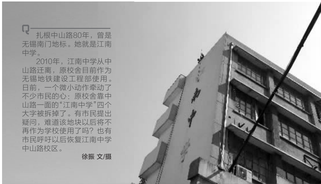
工人正在拆江南中学老校区的校名
