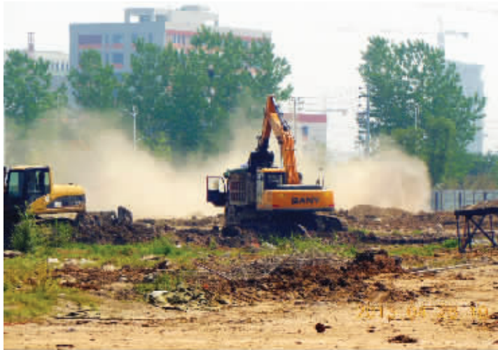
白下科技园的G40住宅项目工地太脏了 通讯员供图
