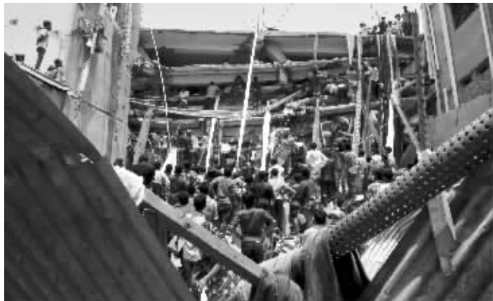
24日,救援人员在孟加拉国首都达卡郊区萨瓦尔镇大楼坍塌现场工作 新华社发(沙里湖·伊斯摄)
