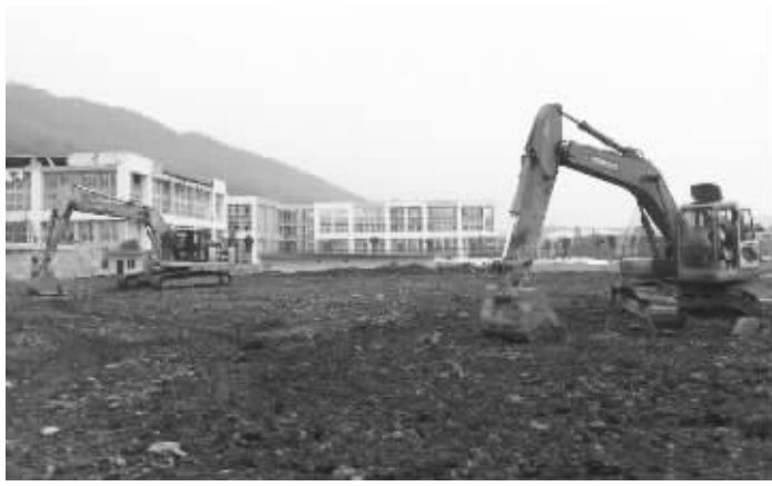
无锡市交通工程有限公司救援队施工人员正在对芦山县临时安置房场地进行土地平整 无锡市交通工程有限公司供图
