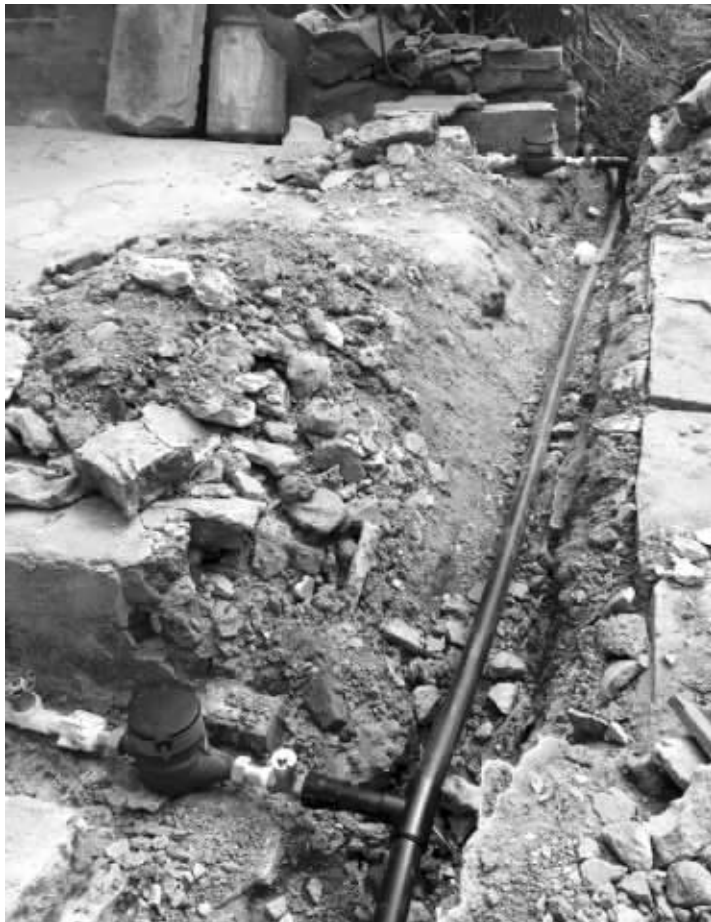
自来水公司正在铺设新管网,预计一周内通水
