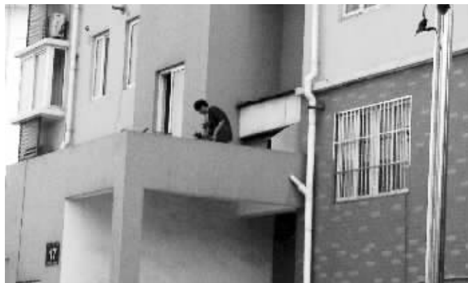
记者走时见到,这名男子拆除了平台上搭建的木板隔间
