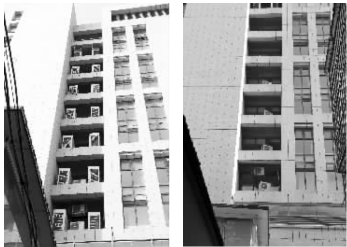
空调移机之前
