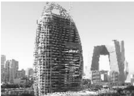
新大楼正在做外部装饰 周琦供图
