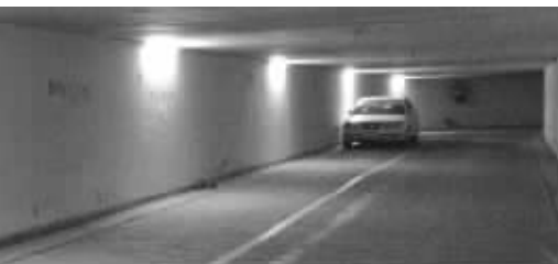
某区政府地下停车场车位很空
