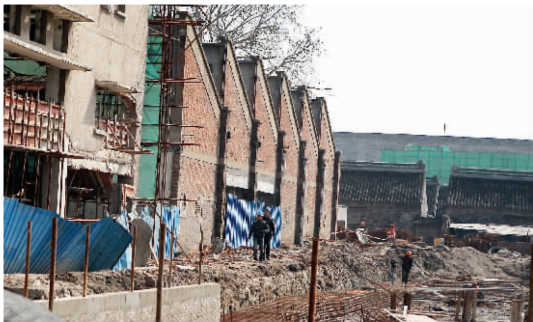
正在改造中的老城南记忆馆 现代快报记者 顾炜 摄
