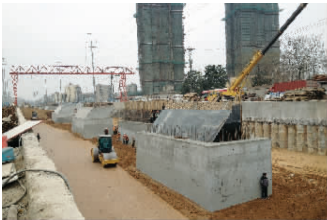
中央北路隧道段正在施工中
