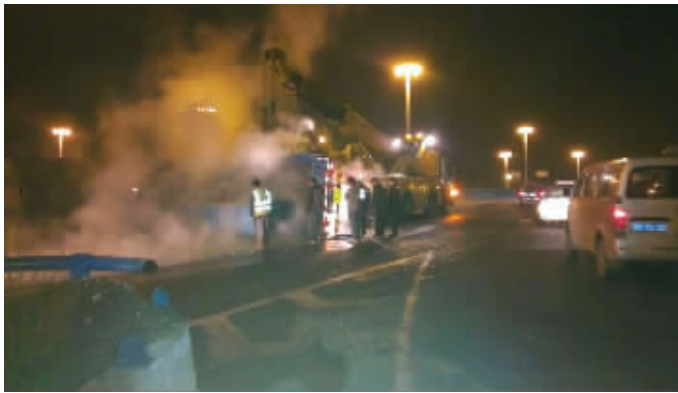
翻车现场热气腾腾 报料人供图
