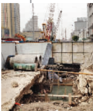
工地已经围挡, 挖了个大坑 现代快报记者 李雨泽摄
