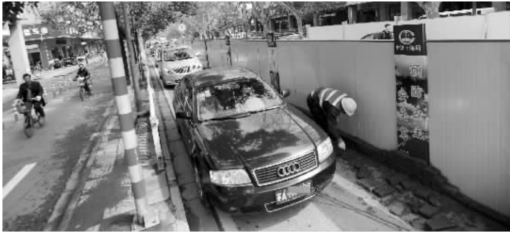
昨天在中华路上,车辆经过围挡缓慢通行 现代快报记者 施向辉 摄
