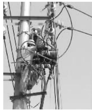
抢修人员正在维修 报料人供图
