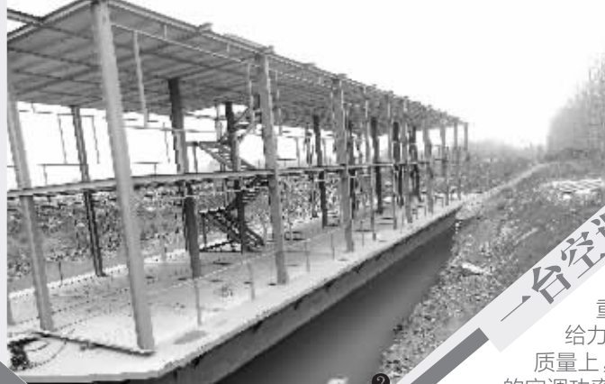
①江滩上运进来的土,已经做成道路 ②驳船四周都已经做好框架
