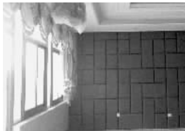
其中一处房间墙壁做了软包装
