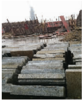
揽月湾改造施工现场
