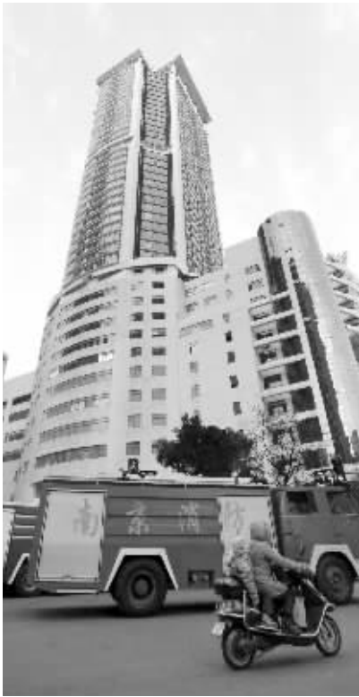
天安大厦有火情,消防车及时赶到现场
