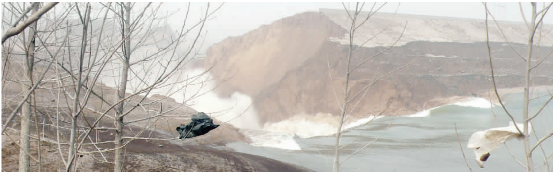
2月16日,山西省洪洞县坝体垮塌现场 CFP供图
