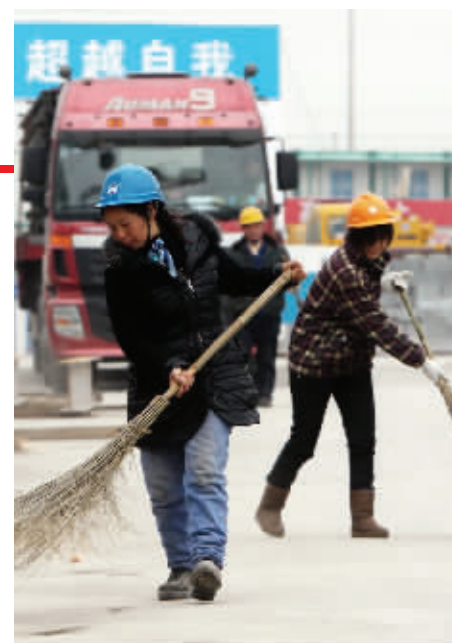
河西青奥村工地
