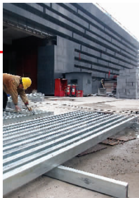
河西新城大厦续建商务办公楼工地
