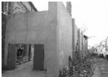
威机公司锻造车间外建造的隔音墙
