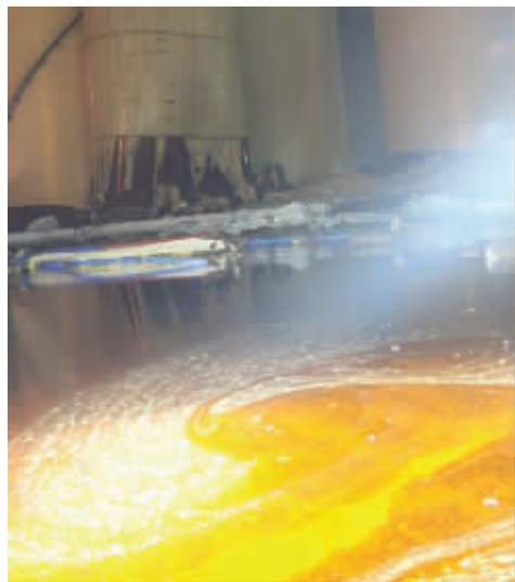
油罐爆裂后豆油漫过整条道路
