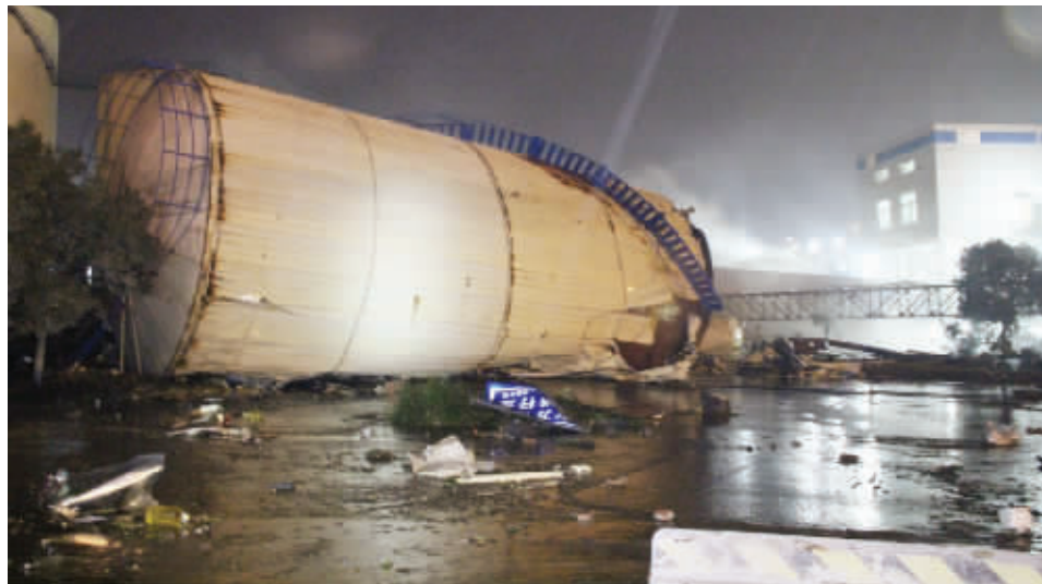
倒在旁边的一个小储油罐 知情人供图
