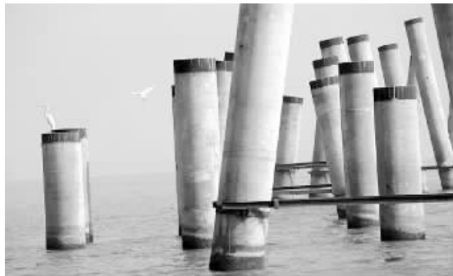
被疑“烂尾”的石桩
