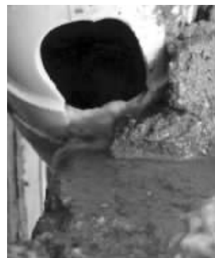
污水管上的洞 袁先生供图
