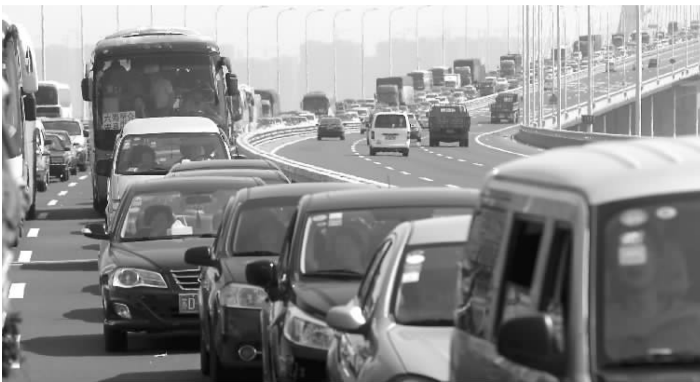
2012年9月30日高速免费第一天,南京长江三桥南北过江严重拥堵。春节高速免费时间公布,大家担心这种拥堵现象会重现 现代快报记者 顾炜 摄
