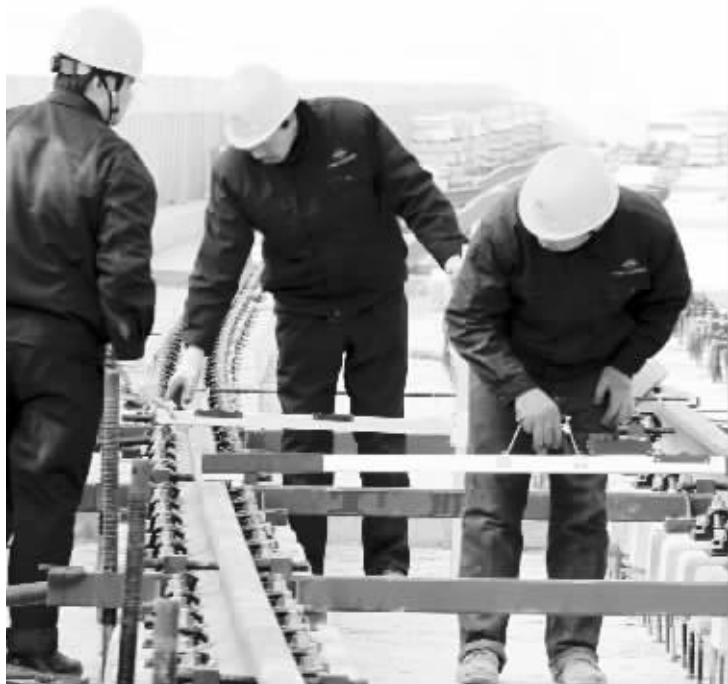
无锡地铁2号线高架段,工人们正在进行轨道安装作业
