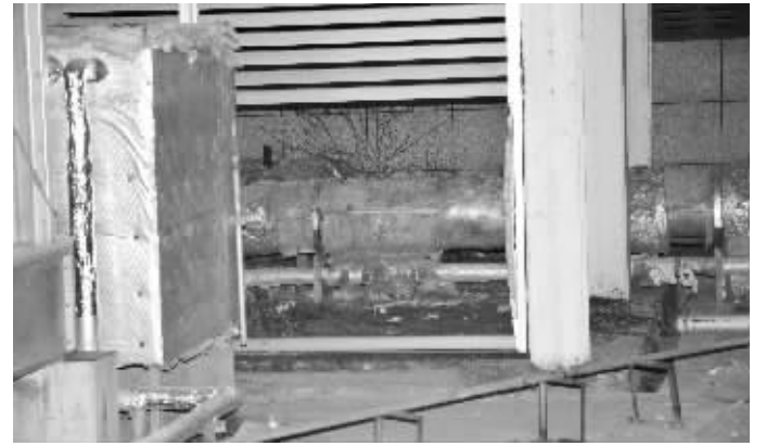
缺损的栏杆都是被偷走的 通讯员 施大江 摄
