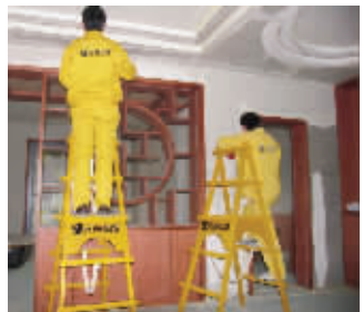
如果不能确保油漆和乳胶漆工程在停工前完成，就尽量不要开工
