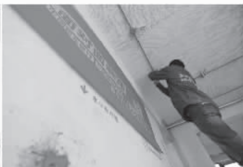
□ 面对面标准施工现场
