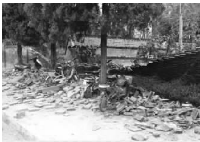
倒塌的围墙砸坏了多辆电动车 图片来自网络
