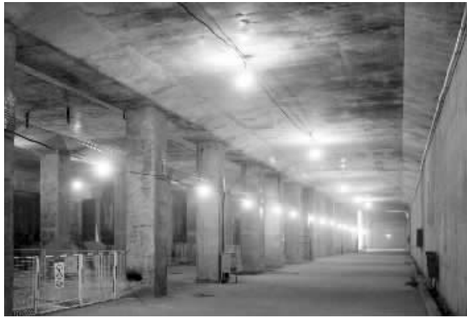
三阳广场站主体结构工程 何春辉 摄
