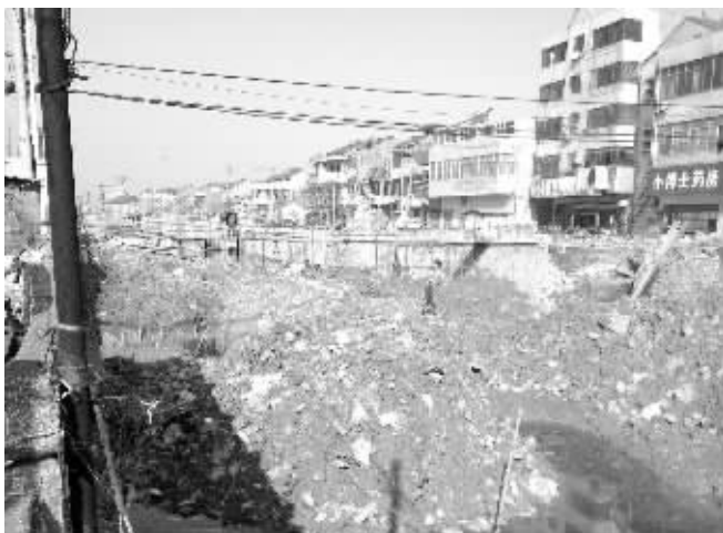
正在重建中的上黄镇藕石桥 葛小林 摄
