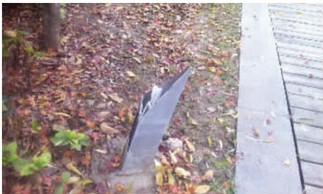
景观灯损坏,电缆被盗 匡笠 摄
